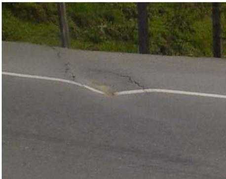
*Figura 14.* Hundimiento del pavimento.
