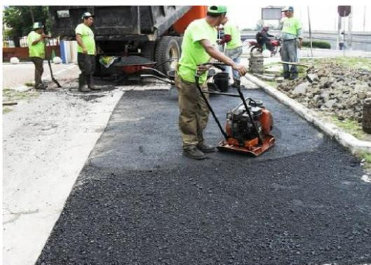
*Figura 5.* Aplicación de mezcla asfáltica en frío.
