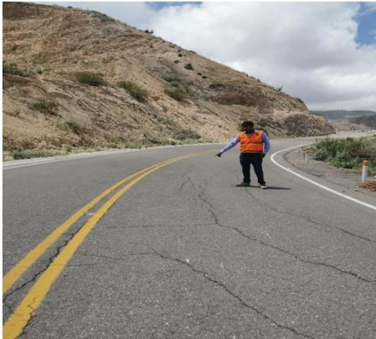
Figura 2. Falla pavimento tipo grieta longitudinal.
