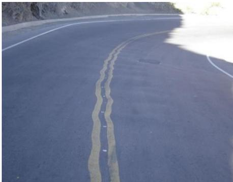
*Figura 13.* Ondulación del pavimento.
