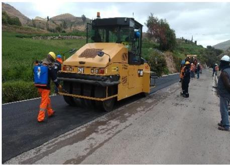
*Figura 41. Rodillos de neumáticos.*
