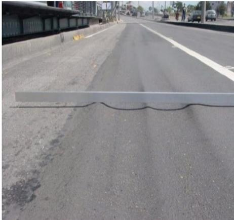
*Figura 15.* Ahuellamiento del pavimento.
