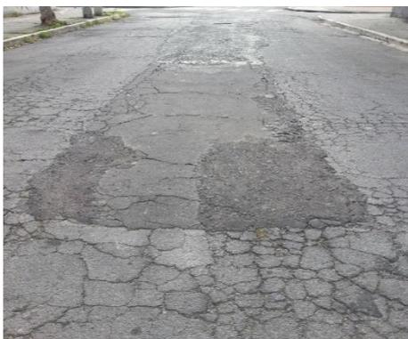
*Figura 10.* Parches deteriorados.
