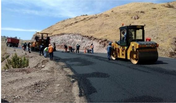
*Figura 4.* Aplicación de mezcla asfáltica en caliente.
