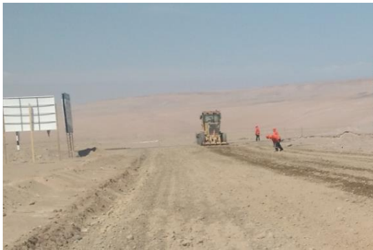
Figura 18. Esparcido del material de sub base con motoniveladora.
