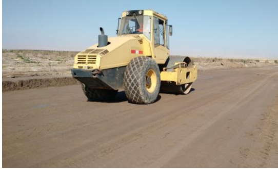
Figura 15. Compactación de la sub rasante.
