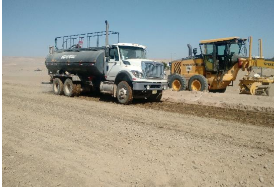
Figura 19. Humedecido del material para sub base granular.
