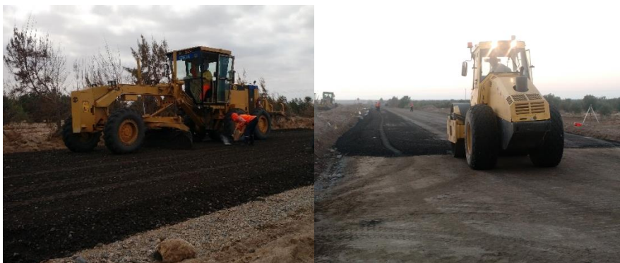
Figura 24. Esparcido y compactado de base estabilizada con emulsión asfáltica en pista.
