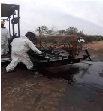
Figura 25. Riego de liga para colocación de mortero asfáltico.
