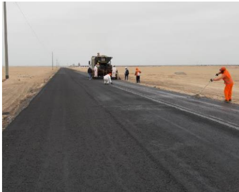
Figura 27. Aplicación final de mortero asfáltico en pista.
