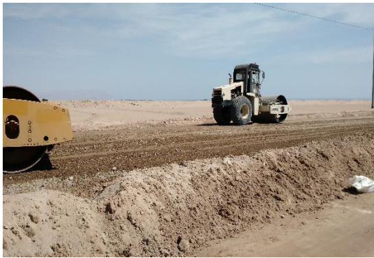
Figura 20. Compactación del material de sub base.
