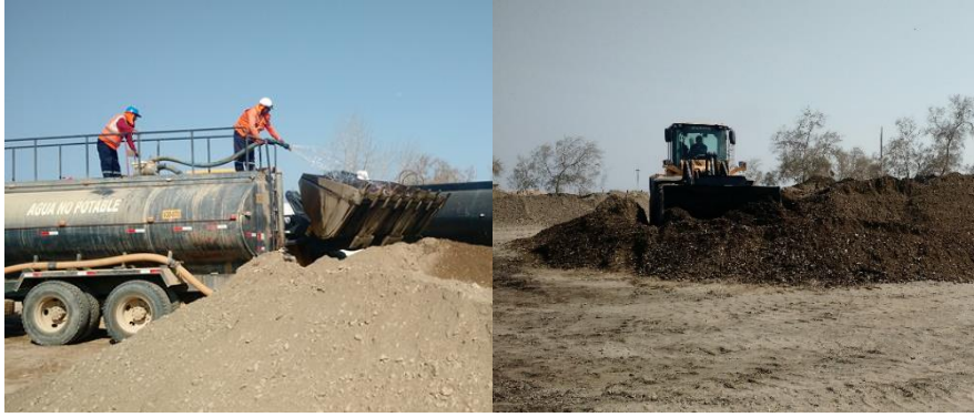
Figura 22. Humedecimiento del material para conformación de base estabilizada.
