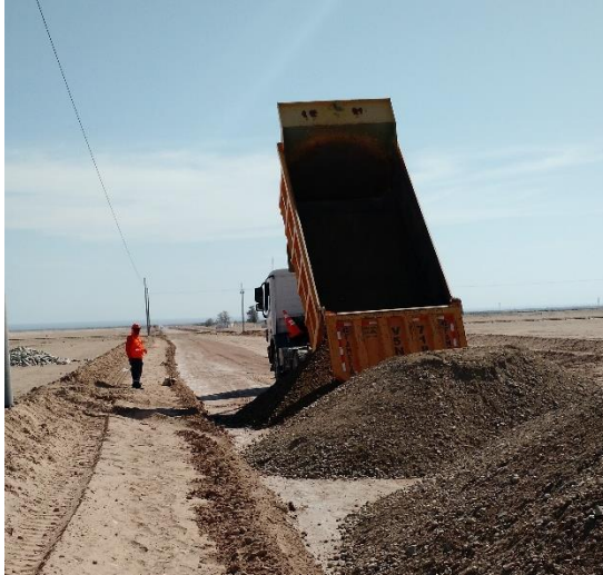
Figura 17. Colocación en pista del material de sub base.
