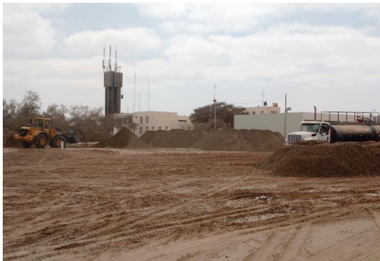
Figura 21. Depósito de material para preparación de base estabilizada.
