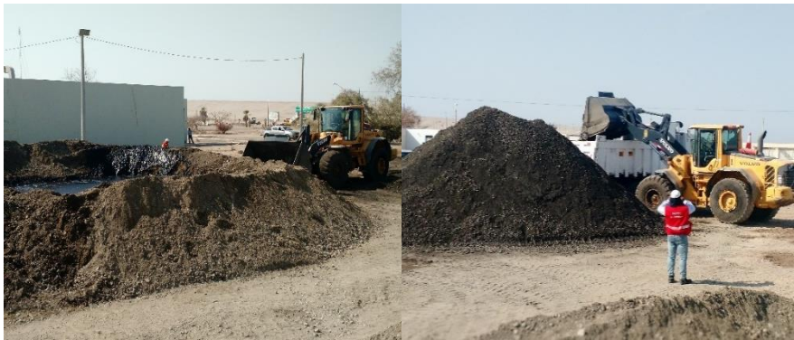
Figura 23. Adición de emulsión asfáltica CSS-1h y batido con el material humedecido.
