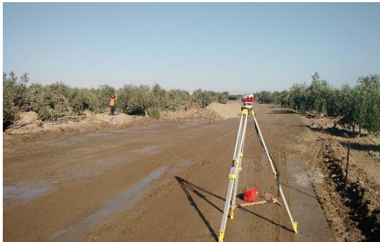
Figura 16. Nivelación topográfica en sub rasante.
