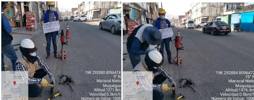
Figura N.- 18 muestra lado derecho Extracción de carpeta asfáltica
