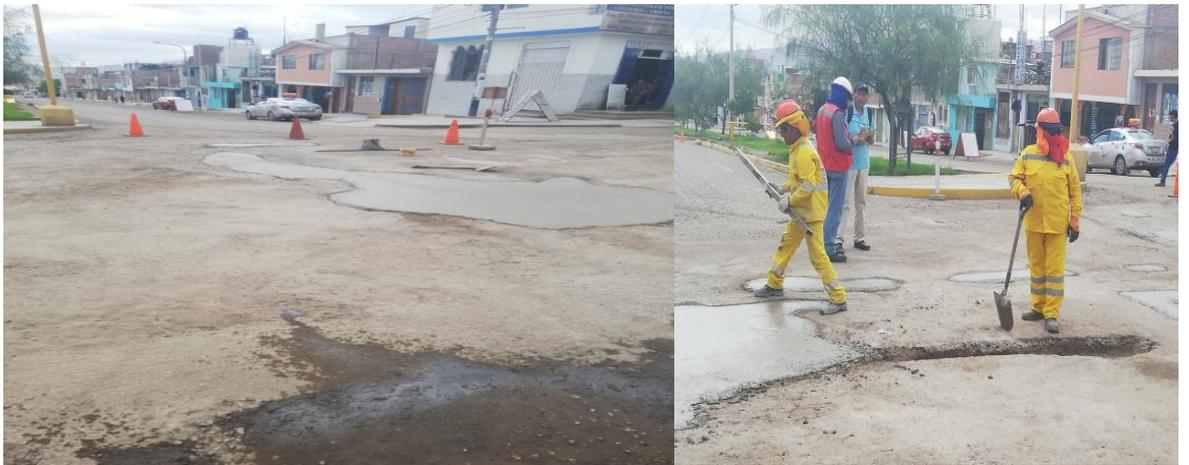
Figura 32 Barrido y Reemplazo, nivelación con concreto simple, progresiva 0+020
