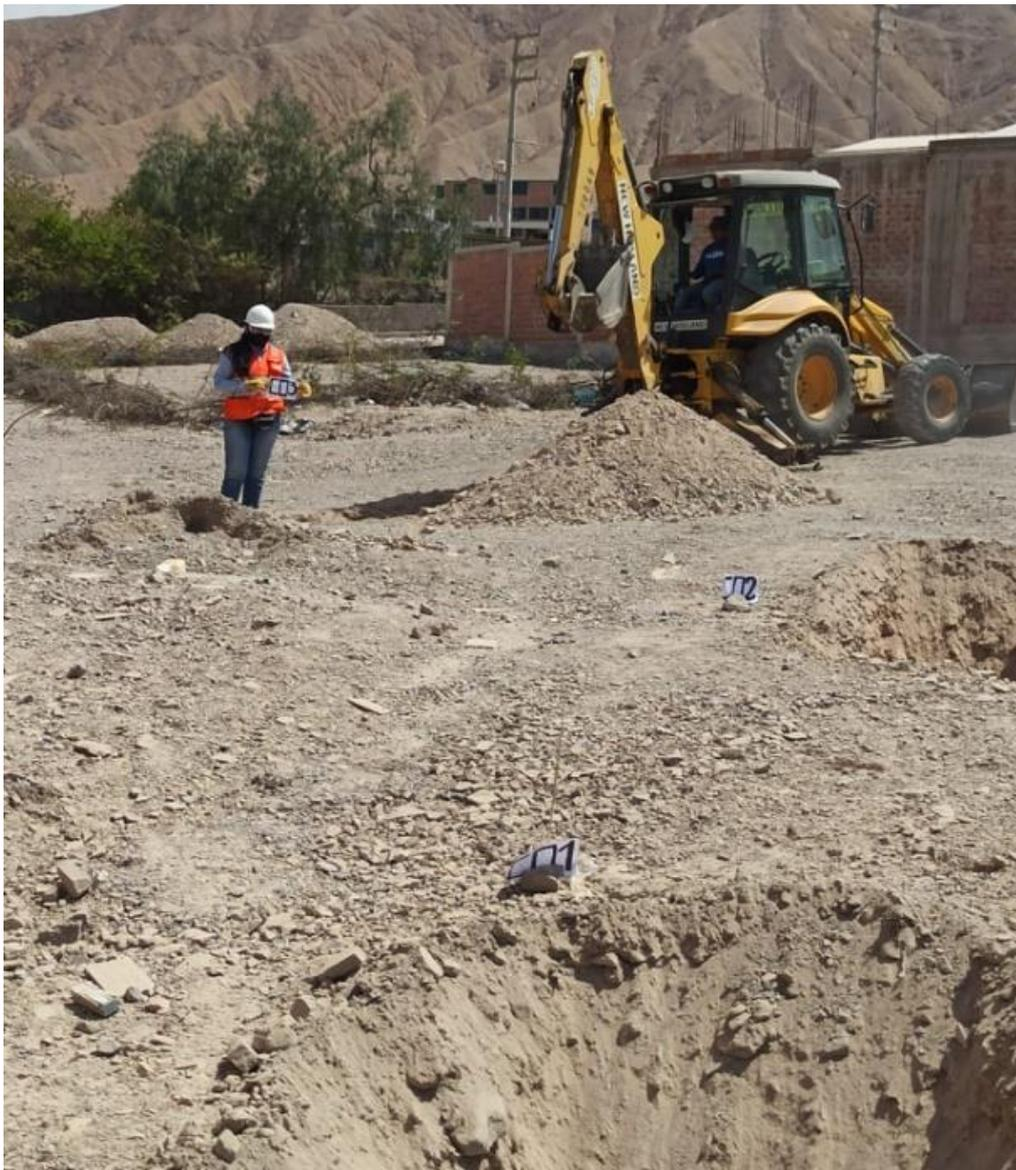
*Figura 24.* Ejecución de Calicatas con Retroexcavadora.
