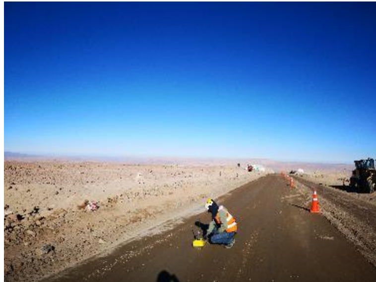
Figura N° 10: Ensayo de densidad in situ Método Nuclear Fuente: Elaboración Propia
