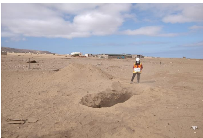
Figura 23. Vista panorámica de la calicata 02
