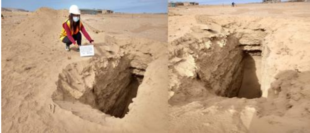
Figura 24. Vista de Calicata 02 con profundidad de 3 metros
