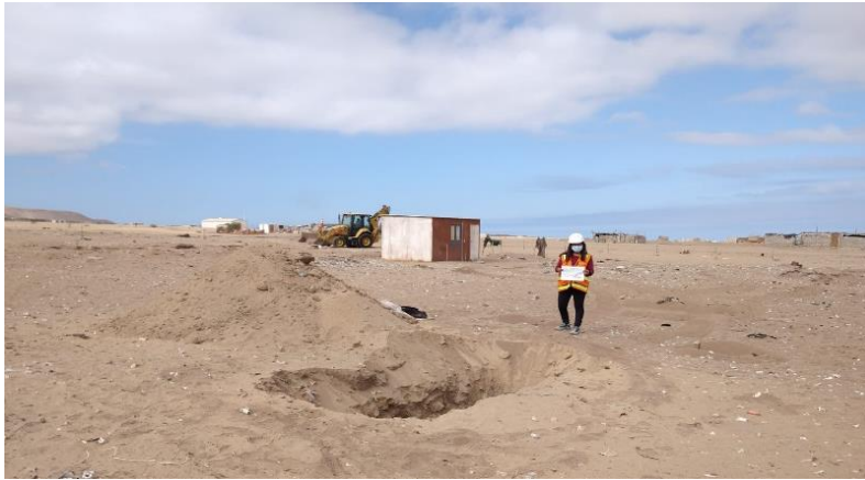
Figura 21. Vista panorámica calicata 01
