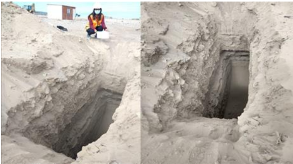
Figura 22. Vista de Calicata 01 con profundidad de 3 metros
