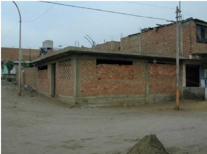
Figura 16. Vivienda techada en concreto armado.
