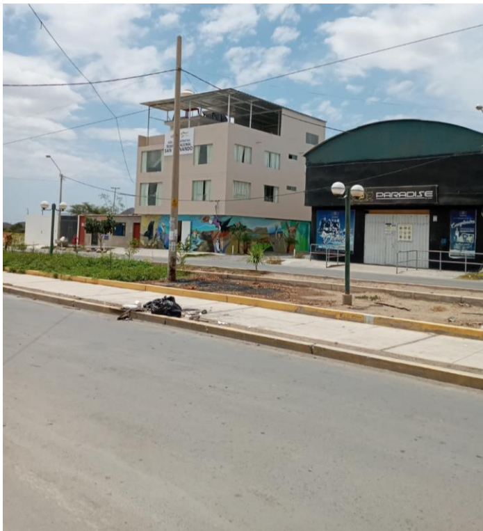
Figura 48. Viviendas sin pendientes
