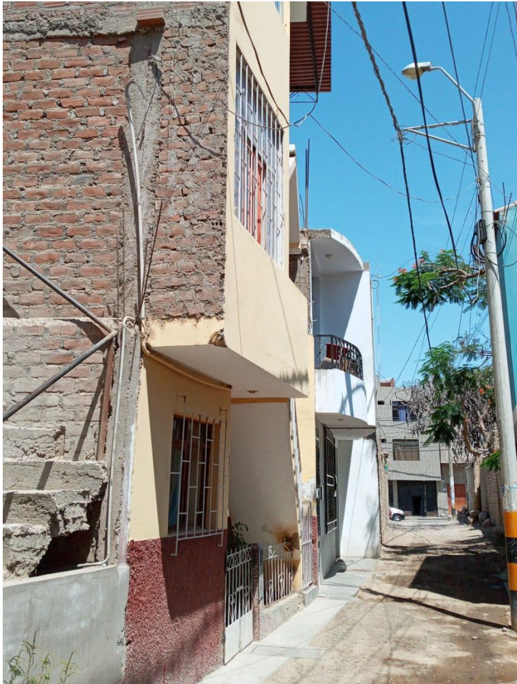
Figura 31. Muros de King Kong Artesanal (vivienda 06)
