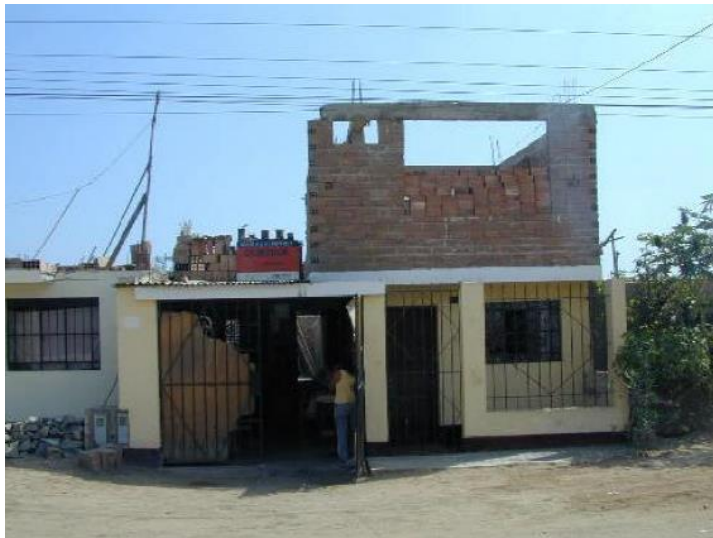
Figura 18. Vivienda con muros proyectado para el segundo piso.
