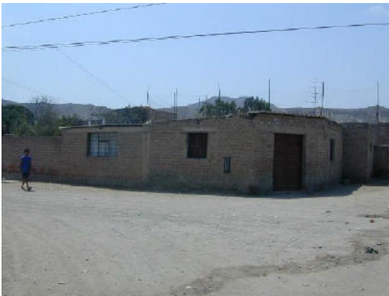
Figura 14. Vivienda con techo provisional.
