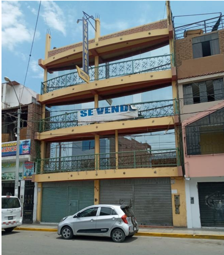
Figura 32. Vivienda de tres pisos (vivienda 07)
