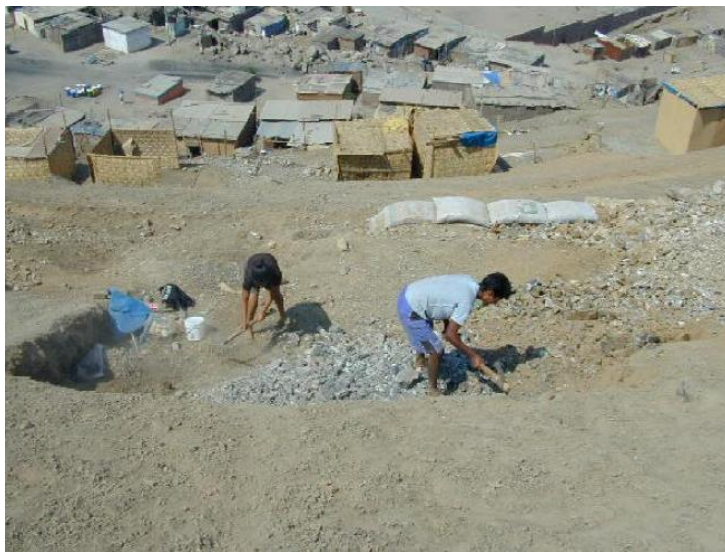
Figura 9. Nivelación manual del terreno.
