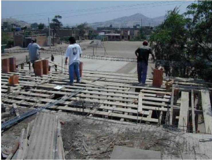
Figura 15. Armado del encofrado para el techo.
