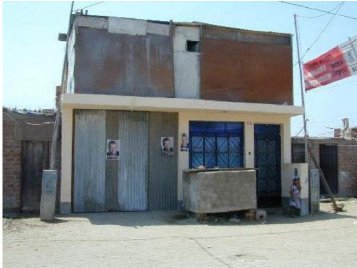
Figura 17. Vivienda tarrajada con muros en el segundo piso.
