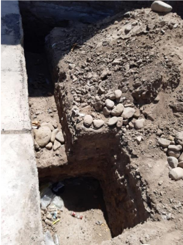
Figura 11. Excavación de zanjas para la cimentación.
