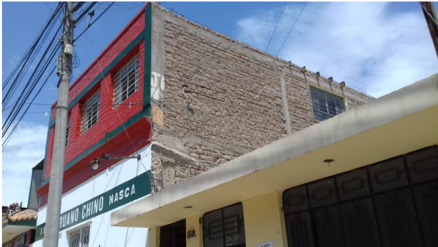
Figura 2. Construcción con ladrillos artesanales.
