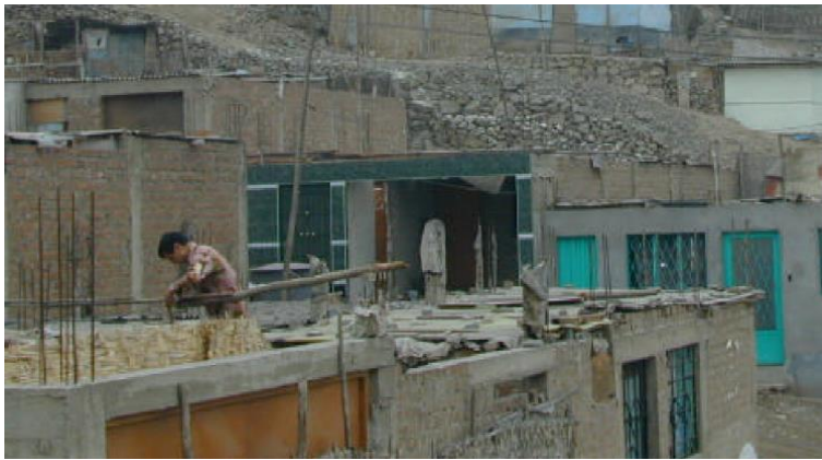
Figura 13. Colocación de techo provisional.
