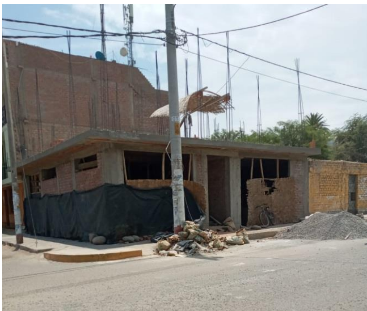
Figura 28. Vivienda de un piso (vivienda 02)
