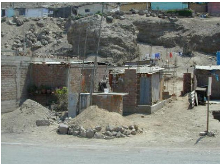
Figura 12. Cimentación y levantamiento de algunos muros y columnas.
