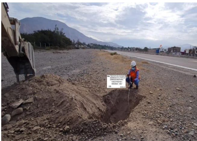
Figura 31. Vista frontal de la calicata N° 01
