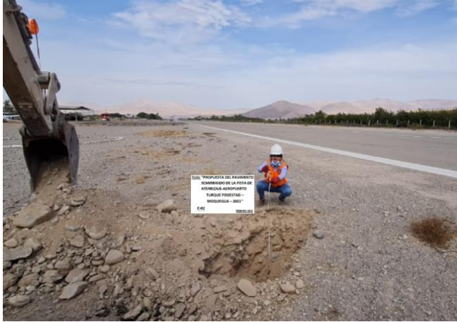
Figura 32. Vista panorámica calicata N°02
