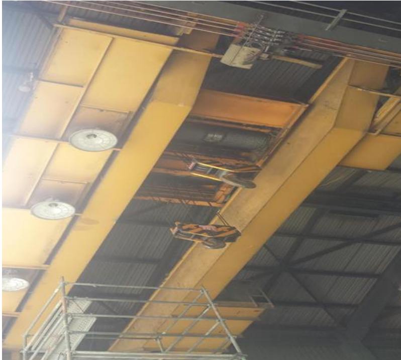
Puente Grúa Bahía de Soldadura Antiguo
