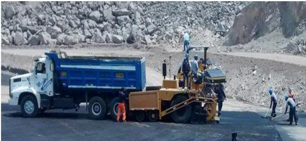
*Nota:* Mortero asfáltico o slurry seal como tratamiento superficial para pavimentos de afirmado.
