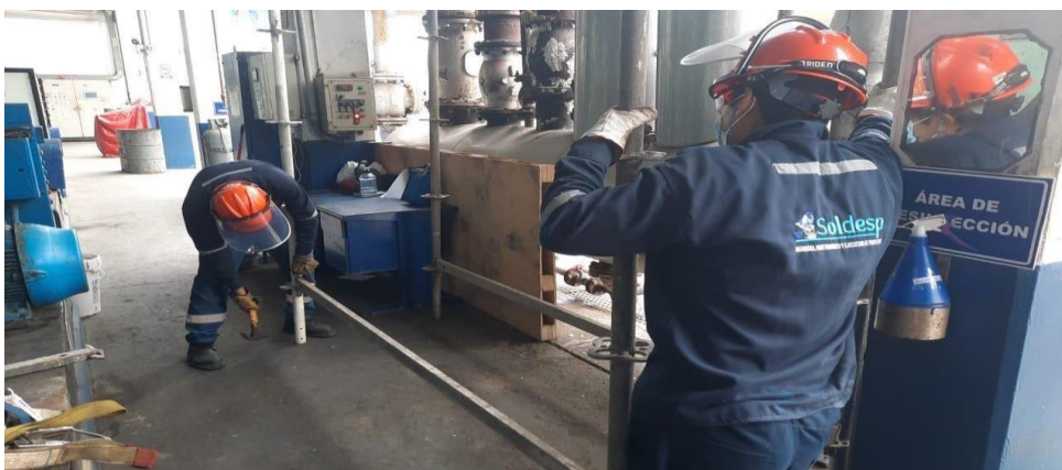
Proceso detallado de montaje y despliegue de andamios
