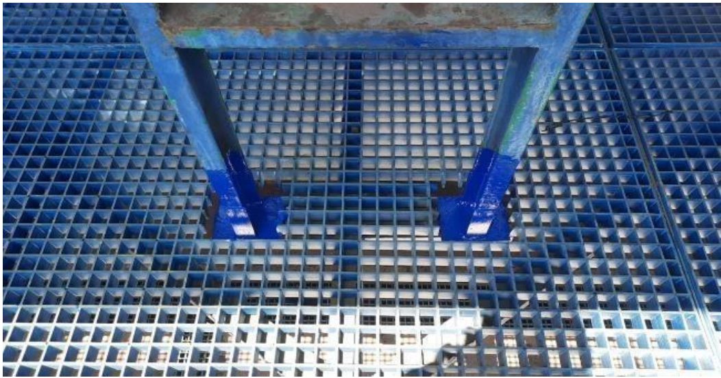
Estructura sin pintar
