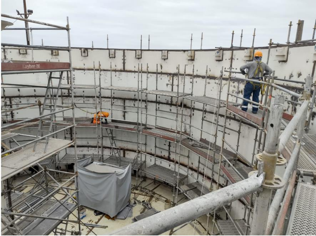
Instalación del cuerpo del tanque.
