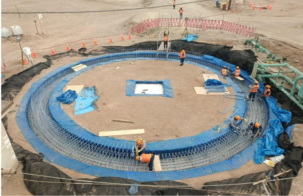
Preparación del terreno para la instalación del tanque de agua.
