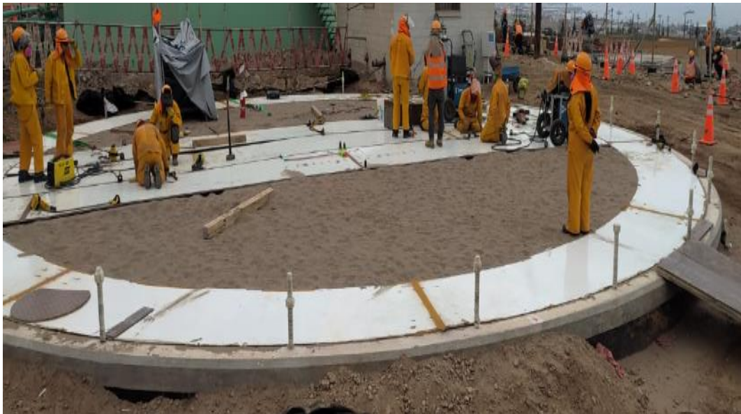
Instalación de la base del tanque.
