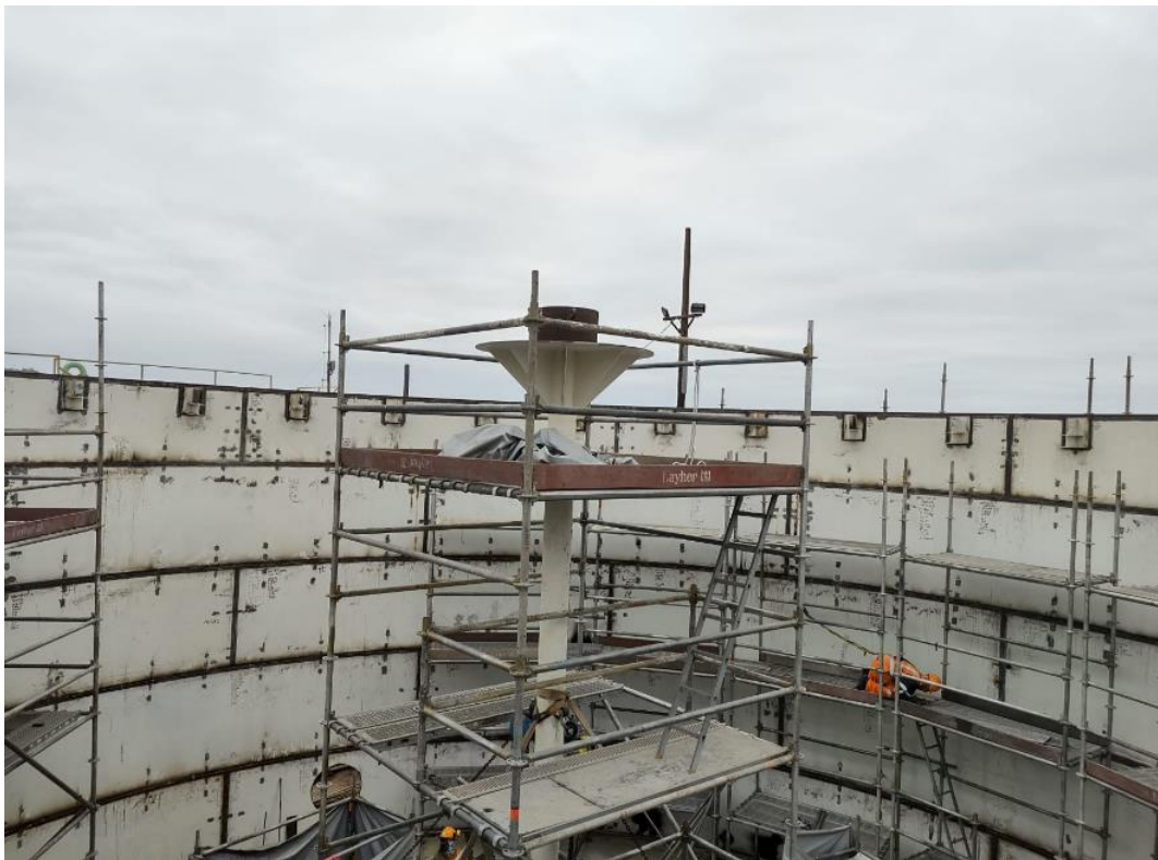
Instalación del cuerpo del tanque.
