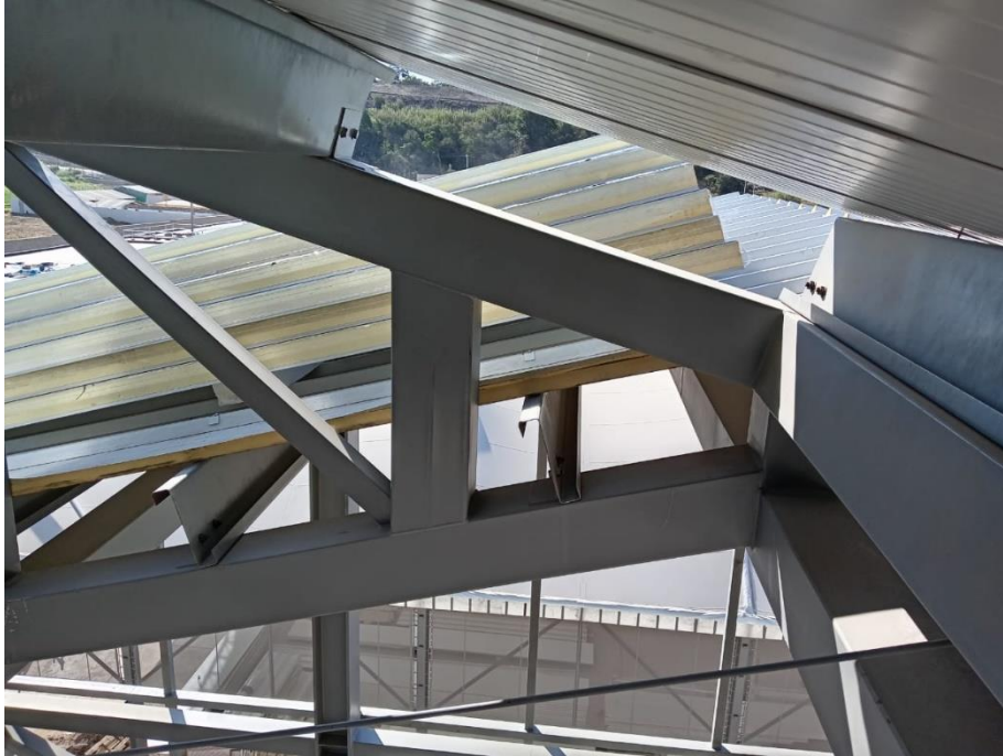
Colocación de cobertura
