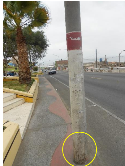
Figura 1. Poste Defectuoso
