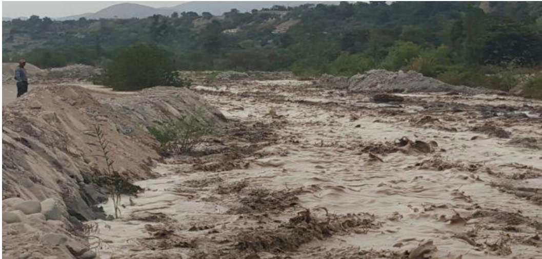
Figura 3. Inundación en río Moquegua que afectó estructuras hidráulicas.
