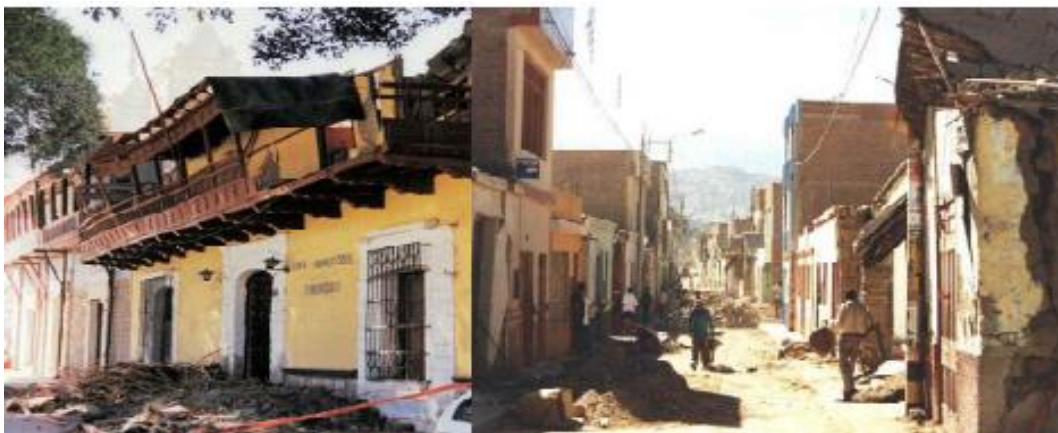
Figura 2. Fotografías de daños ocasionados en terremoto del 23/07/2001.
