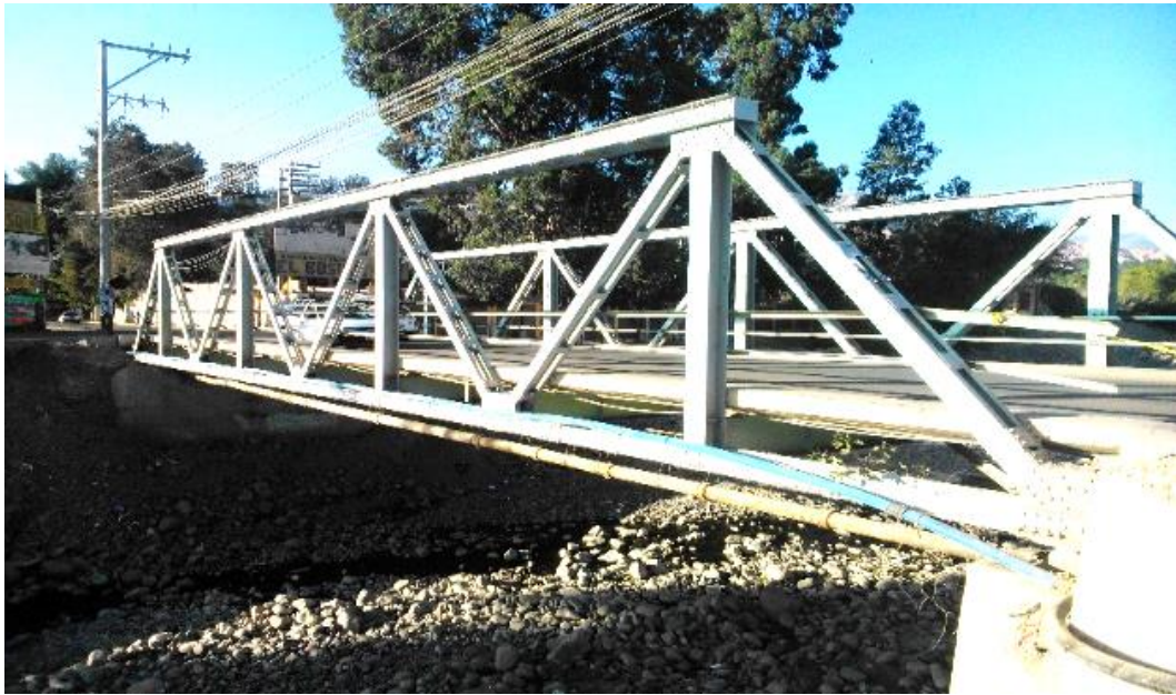
Figura 50. Fotografía del puente existente “La Villa”.
